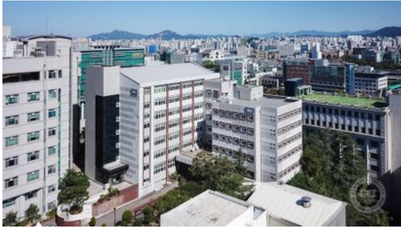
• 제1음악관 외관 (2020.09.29 촬영) 한양대학교 서울캠퍼스에 위치한 건물
