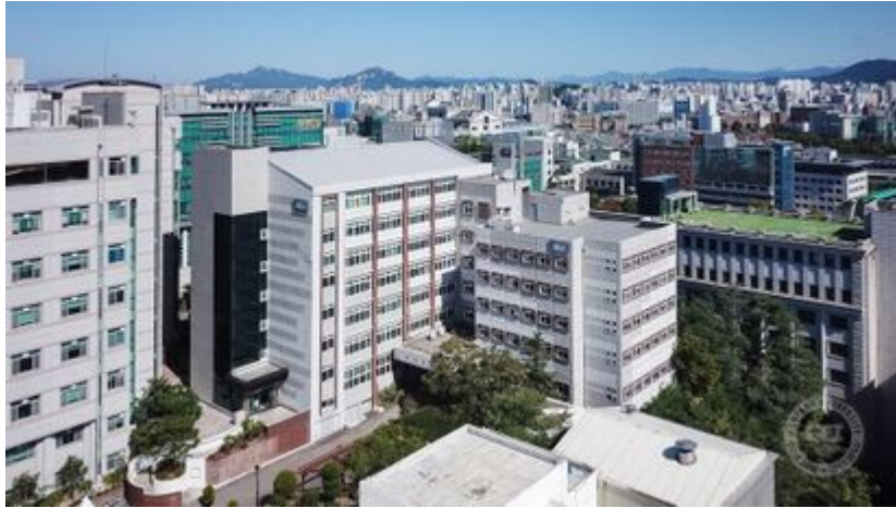
• 제1음악관 외관 (2020.09.29 촬영) 한양대학교 서울캠퍼스에 위치한 건물
